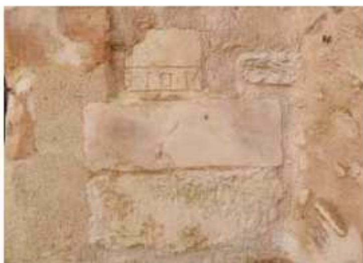
Détails des murs en enduit à pierre vue avec la réutilisation de pierre d'origines diverses.
