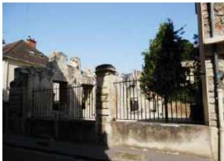
La vue des éléments de fondation bordant la rue des Jacobins.
