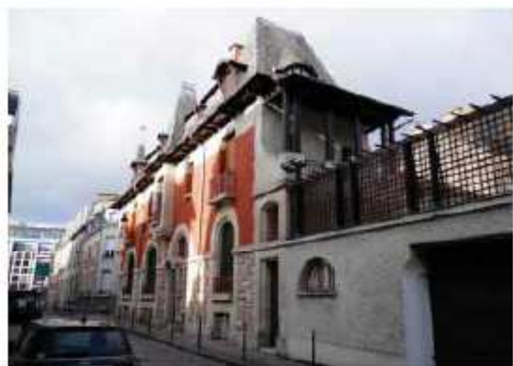
Une composition architecturale dynamique, accentuée par des matériaux aux textures variées
