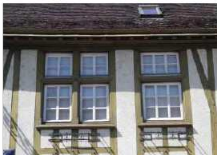
Les baies à meneaux de bois avec des menuiseries à petits bois et des décors en ferronnerie (n°24).
