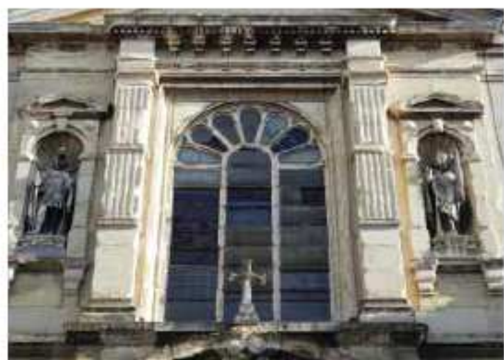
Détails des ornements et des sculptures de la façade préservée du XIX ème siècle de N. Brunette.
