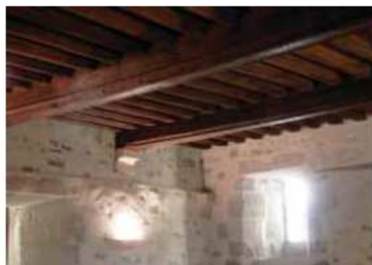
Les parois de pierre en enduit à pierre vue révélant les percements très anciens, les appuis de poutre...
