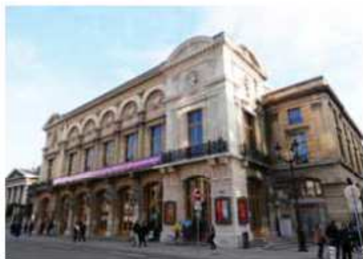
La façade majeure en pierre de taille datant du XIX ème siècle en avancée sur la place Myron Herrick.
