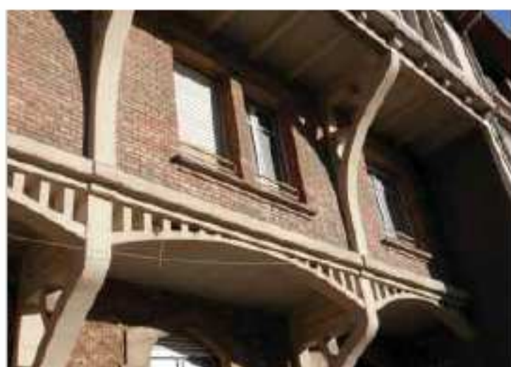
La forme ondulée des consoles en béton, supportant les niveaux en gradins (n°3 bis).
