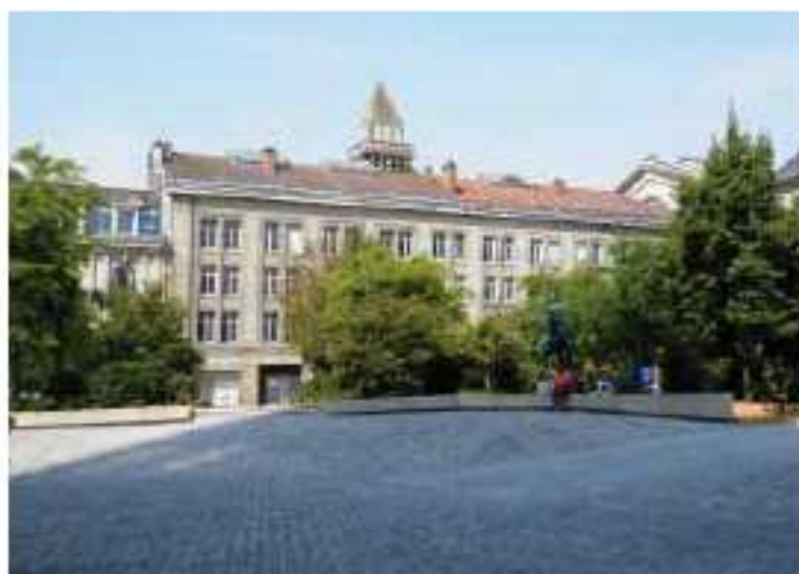
La vue de la façade principale depuis le parvis de la cathédrale à travers le jardin.
