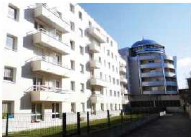
Un objet architectural innovant, en rupture radicale avec son environnement moderne et épurée.
