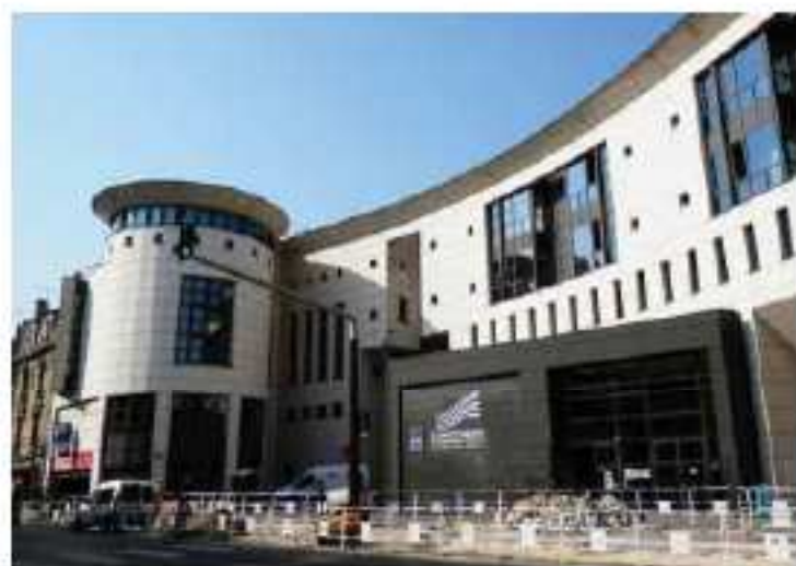
La tour ponctuant la façade monumentale et l'entrée matérialisée par une boîte noire inclinée.
