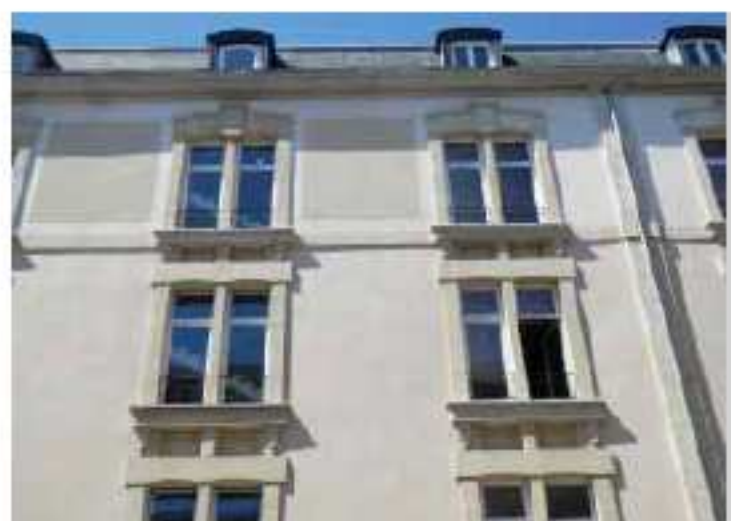
Les baies géminées en pierre, couronnées par des linteaux sculptés et une corniche sommitale.
