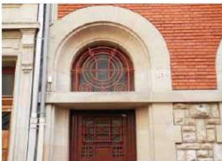
De fines ferronneries de style Art Déco ornant les baies aux menuiseries bois et les garde-corps
