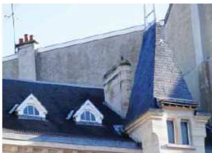
La toiture en ardoise, ponctuée par la fleche des oriels et les lucarnes en bois.
