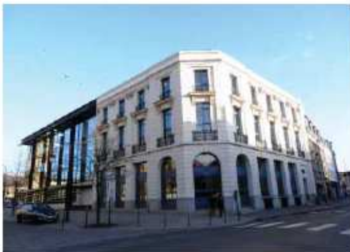
Les façades préservées de style classique de l'ancien hôtel de police.
