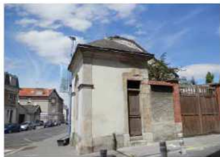
La sobriété du traitement de la façade rue Saint-Sixte.
