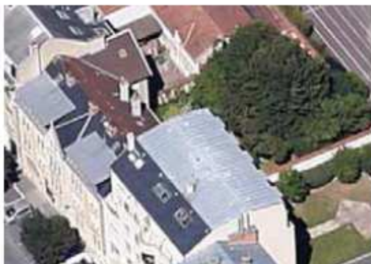
La vue du ciel de l'hôtel particulier de 1927 d'inspiration gothique (n°9).
