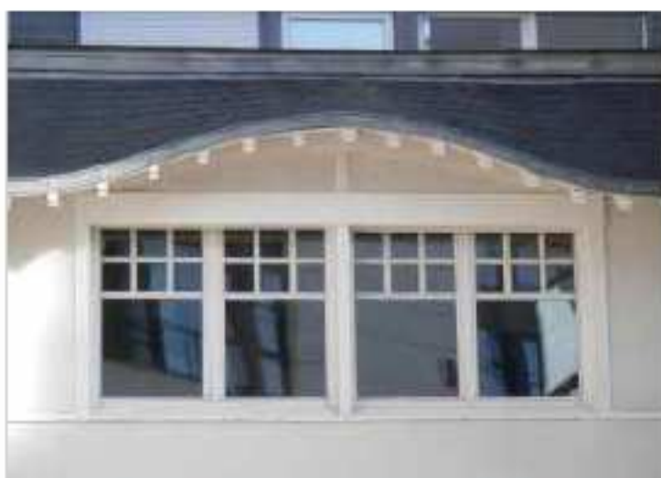
L'ondulation de la toiture, qui souligne la longue baie de l'étage (n°23).
