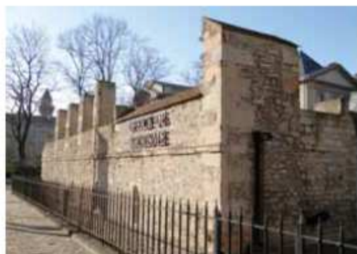
L'élévation des ruines de la Salle du Trésor dont le niveau bâti est plus bas que celui du parvis.
