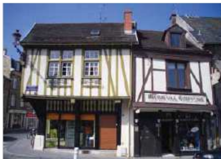
Les maisons en pans de bois apparents à encorbellement avec un commerce (n°22 &24).
