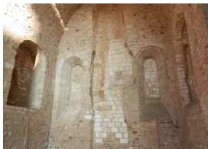
Les baies condamnées de style roman des ruines du chœur conservé.
