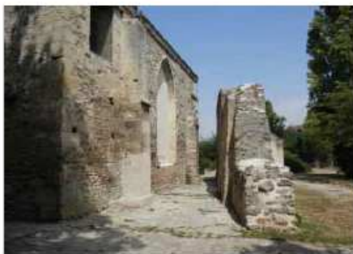
L'épaisseur du rempart composée d'une maçonnerie de pierres de multiples origines.
