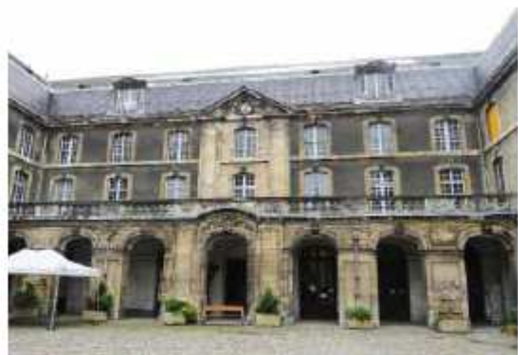
La galerie ajourée à arcades avec terrasse magnifiant la composition architecturale de la cour.
