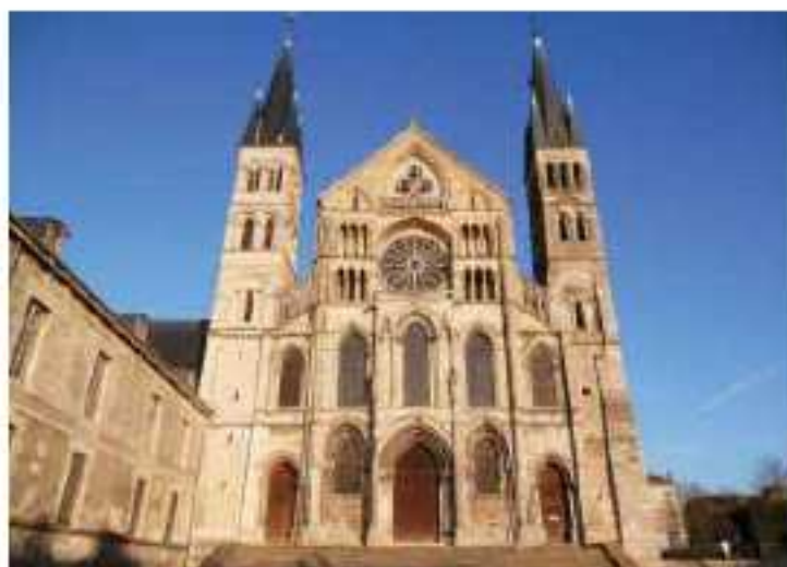
La puissance de la façade monumentale élancée de ses tours ponctuées de fleches, parvis rue Simon.
