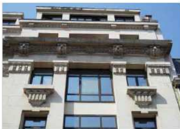
Les décors singuliers des encorbellements, des pilastres, des bandeaux et de la corniche.
