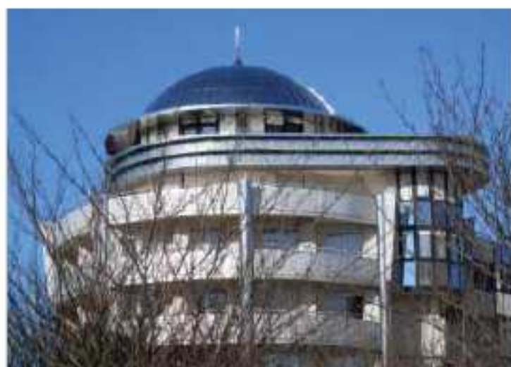
La coupole en inox brillant, soulignée par des rubans métalliques légers cintrés.
