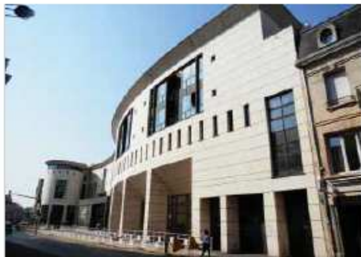
La forme en éclisse de violon de la façade, qui crée une belle ondulation du bâti.
