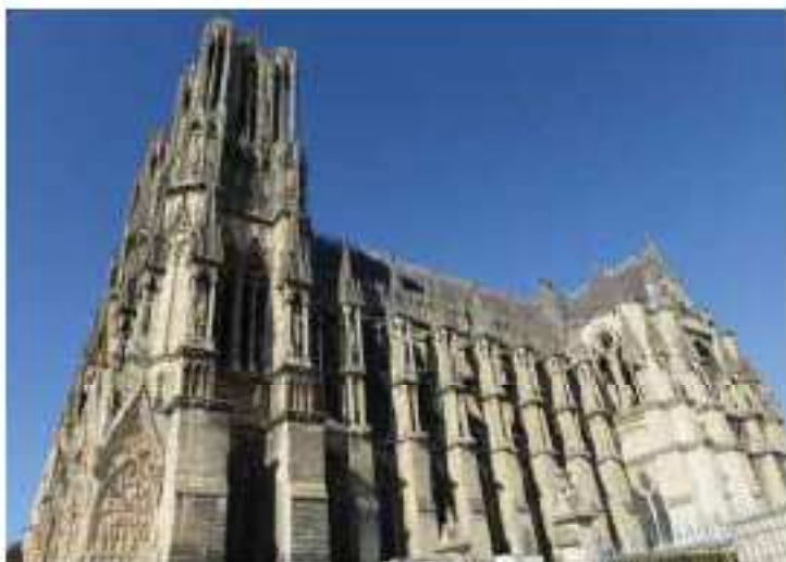
La façade sud, rythmée par les arc-boutants, orientée vers le palais du Tau.
