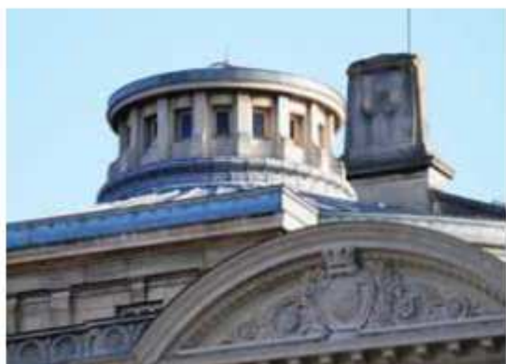
La toiture de la grande salle de théâtre ponctuée d'un lanterneau monumental.
