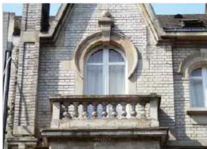
Le garde-corps classique en pierre du balcon et sa baie cintrée à la clé de voûte très prononcée.
