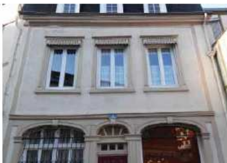
Le détails des baies avec un encadrement et un lambrequin en bois peint (2 rue Saint-Julien).
