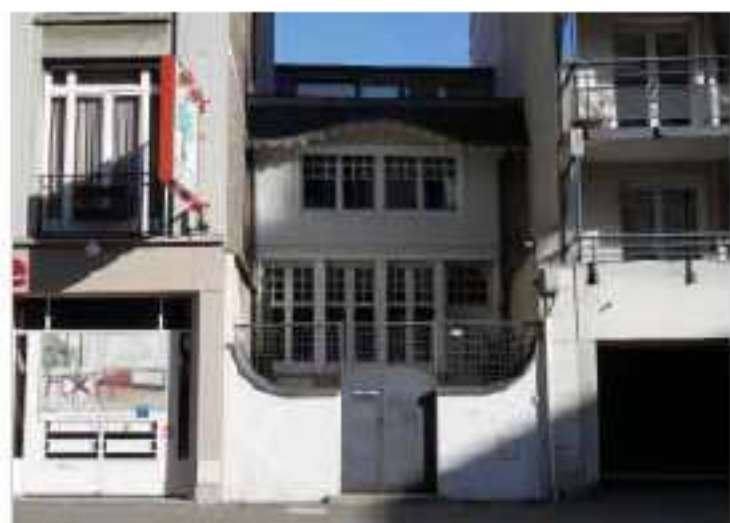
L'une des premières maisons reconstruites à Reims en 1918, avec un jardin avant sur rue (n°23).
