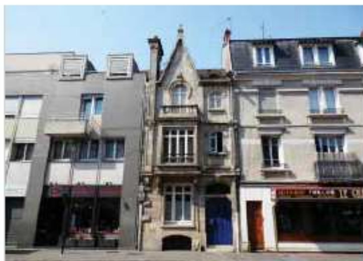
La travée majeure caractérisée par un bow-window très ajouré et une haute lucarne pignon.
