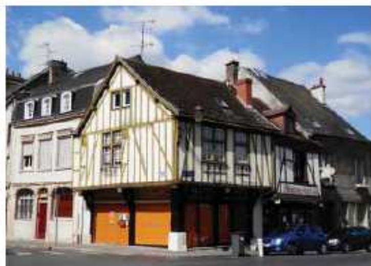
Les encorbellements de l'étage des maisons à colombages du XVI ème siècle classées.
