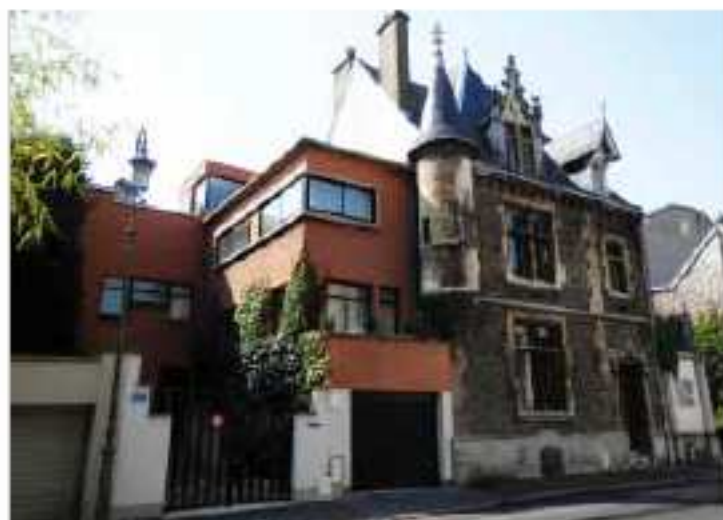
La jonction de 2 maisons (n°1 & 3) accolées à l'architecture opposée.
