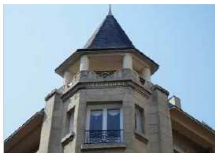
La tourelle d'angle et sa toiture polygonale supportée par des colonnes en belvédère.
