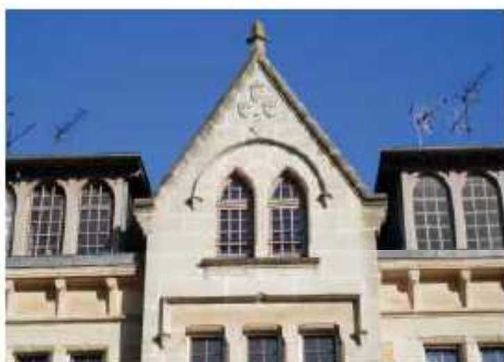
L'édifice en pierre de taille ponctué par une lucarne pignon (n°9), axe de symétrie de la composition.
