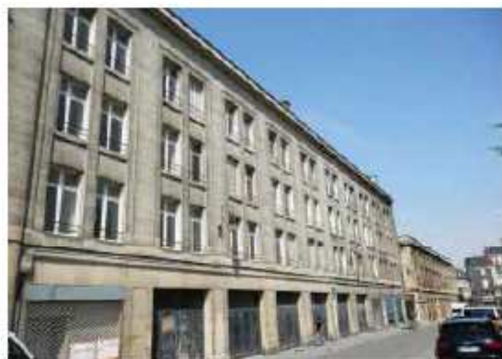
La façade principale percée en rez-de-chaussée par de grandes boîtes (boîtes des camions de pompiers).
