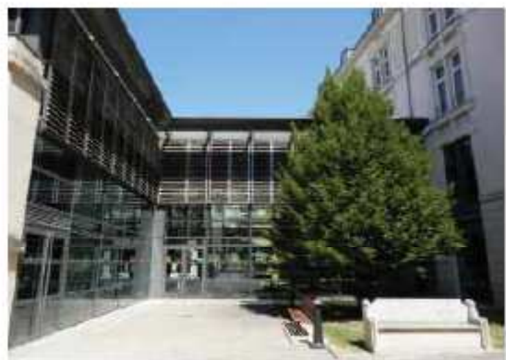
L'extension de verre et de métal encadrée de brise-soleil de bois, qui se détachent de la façade.
