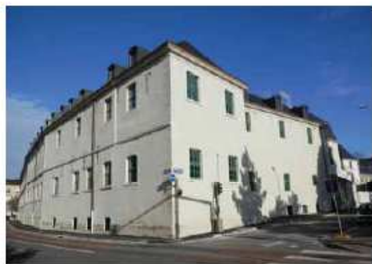
L'aile composée de 22 travées dédiée au FRAC, rue Gambetta, reconstruite au XIX ème siècle.
