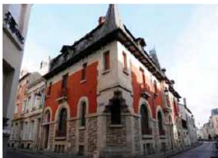
L'angle marqué par une tour de l'angle avec une flèche en toiture
