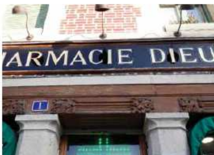
Le linteau en bois sculpté situé au-dessus des baies de la pharmacie en menuiserie bois.
