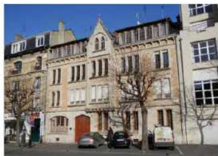
La vue d'ensemble de la façade de l'hôtel particulier (n°9) sur le cours Anatole France.
