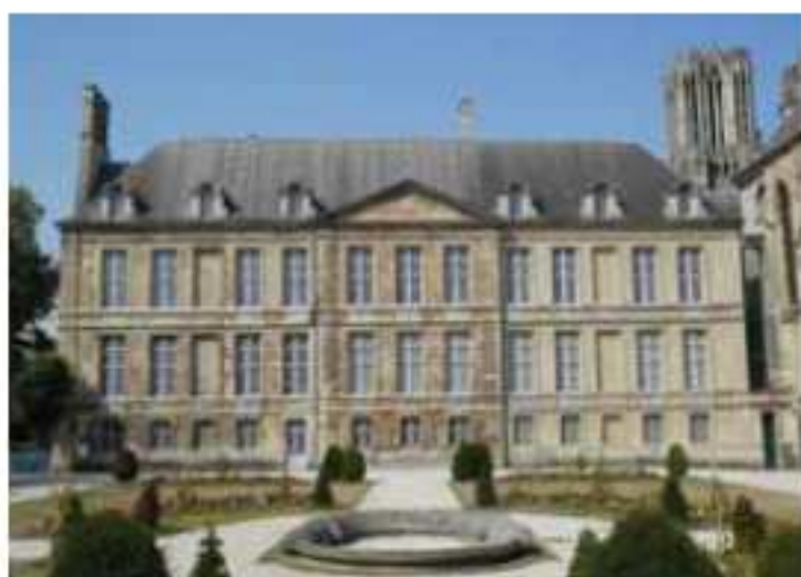
L'architecture remarquable ouverte sur le jardin à la française, côté cours Anatole France.
