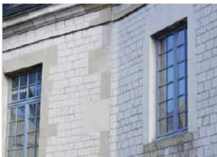
Les baies, aux menuiseries bois teintées, encadrées de pierre sur une façade en carreaux de craie.
