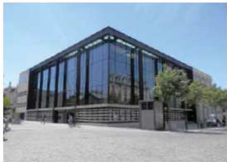
Un volume architectural cubique singularisé par une façade de verre et une façade historique.
