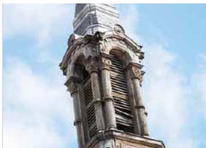
Le clocher en bois décoré de fins ornements éclectiques, ponctué par une fine flèche en ardoise.
