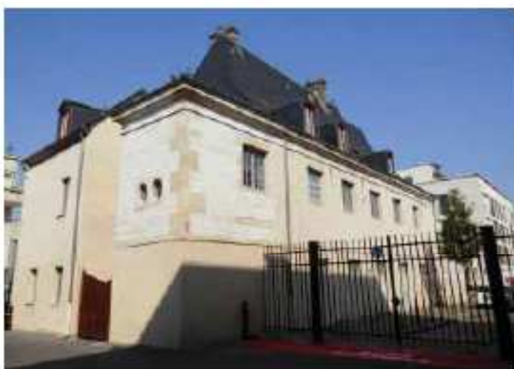
Des oculi et des baies non ordonnancées situés sur les façades latérales.
