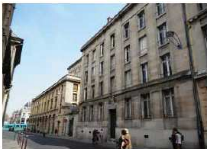
La façade sur la rue Charzy en continuité architecturale avec l'Opéra de Reims.
