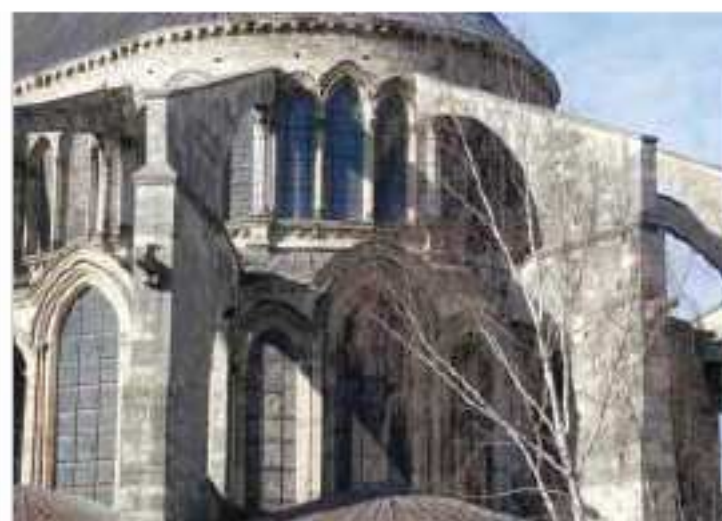
Le détail des ouvertures en ogive, regroupées par 3, insérées entre les arc-boutants du chevet.
