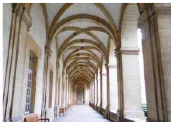
Les voûtes en croisée d'ogives en pierre et en craie sous les arcades classiques du cloître.
