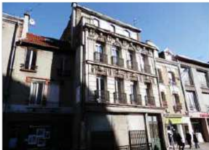
L'immeuble remarquable (n°17), implanté en avant sur la rue suivant l'ancien alignement des façades.
