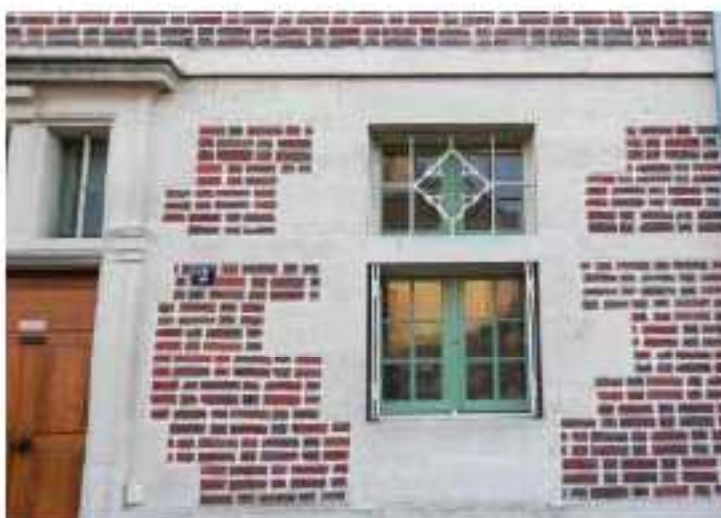
La variété et la qualité des matériaux utilisés : pierre, brique, menuiserie bois, ferronnerie...
