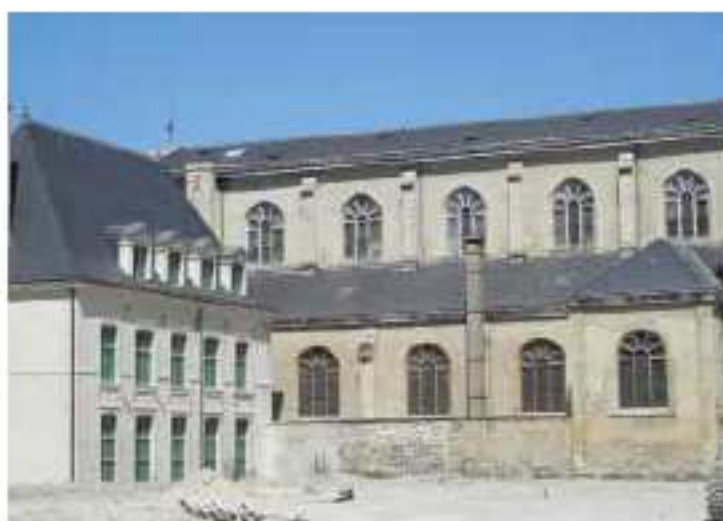
La façade latérale sud, orientée sur la cour intérieure du collège des Jésuites.
