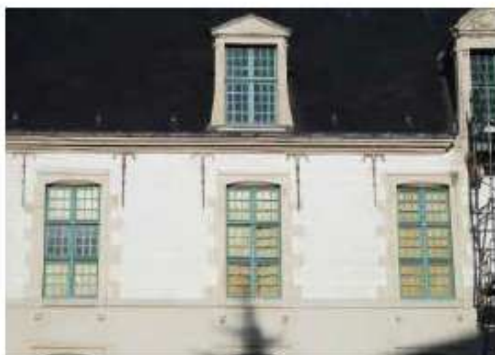
Des baies cintrées aux menuiseries à traverses à petits bois sur des façades en craie.
