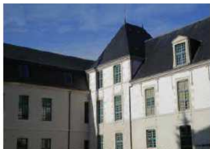
La jonction de deux ailes bâties soulignée par un pavillon plus élevé avec une toiture à croupe.
