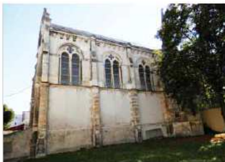
La façade latérale (côté ouest) avec des percements similaires et une petite chapelle sur le jardin.
