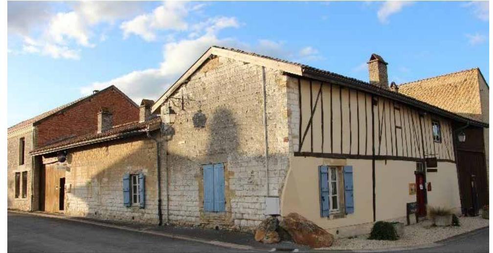
Photo d'un bâtiment traditionnel en pans de bois, torchis et pierre calcaire à Juniville - AUDRR
